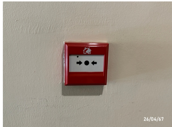
เครื่องแจ้งเหตุโดยใช้มือตึง (Fire Alarm Manual Station)
